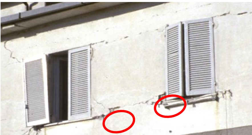
Βλάβες λόγω στροφής (λικνισμού) της τοιχοποιίας εντός του επιπέδου του τοίχου
