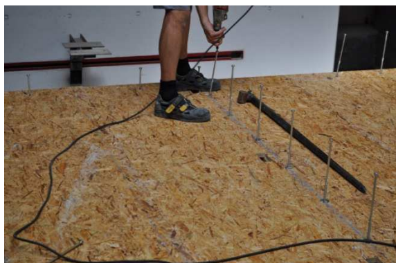
Figura 17: Dettagli di connessione
