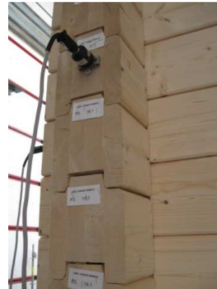
Figura 8: Nodo d'angolo con accelerometro
