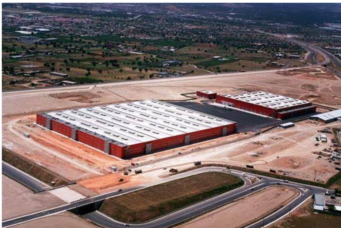
Εικόνα 34. Κτιριακές εγκαταστάσεις ΟΣΕ, Πηγή:[48]
