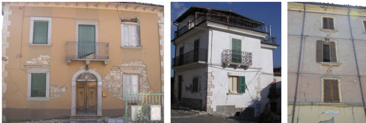
Εικόνα 2.1. Παραδείγματα τύπων αστοχίας εντός επιπέδου με συγκέντρωση βλαβών στους πεσσούς και τις δοκούς σύζευξης (παραδείγματα από τους σεισμούς της L'Aquila το 2009 – αριστερά και κέντρο – και της Emilia το 2012 – δεξιά). (Lagomarsino et al., 2013).
